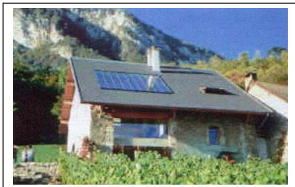
Per quanto riguarda le applicazioni per la produzione di acqua calda sanitaria, i sistemi solari consentono di coprire mediamente il 60-70% del fabbisogno termico annuo dell'utenza, con punte del 100% nei mesi estivi.
